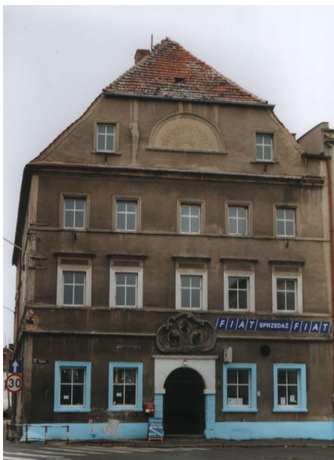
Abb. 6: Im Jahr 2000 befand sich in dem Gebäude ein Autohaus, heute beherbergt es ein Bekleidungsgeschäft
