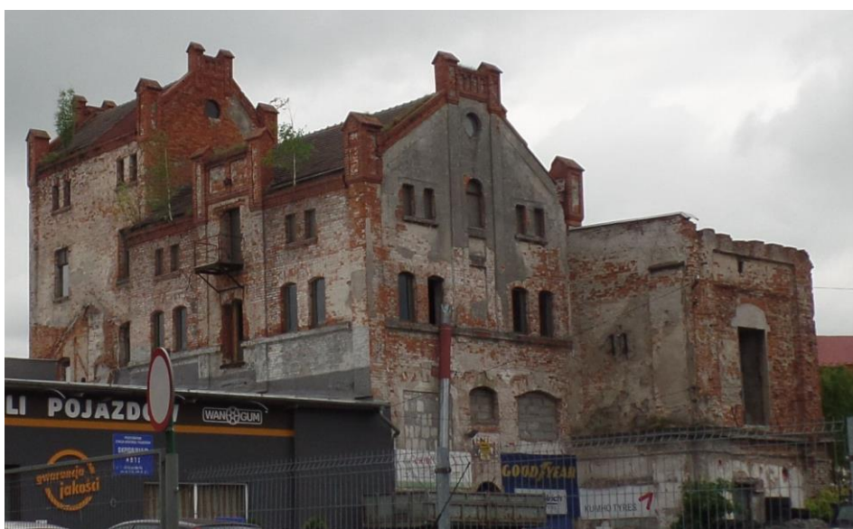
Abb. 15: Die Gebäude der Brauerei Scheffler im Jahre 2021
