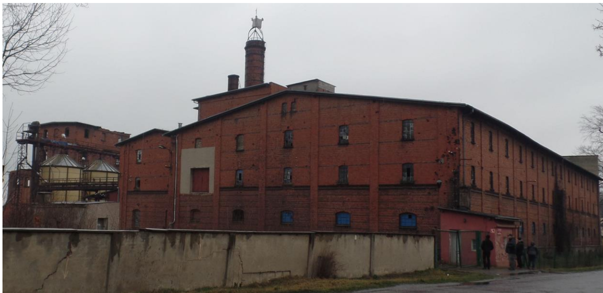
Abb. 11 Das Mälzereigebäude im Jahr 2015
