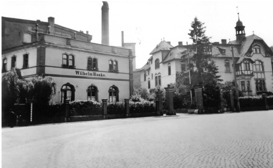
Abb. 6 Die Hanke-Mühlenwerke und Malzfabrik (Fotografie, vor 1945)
