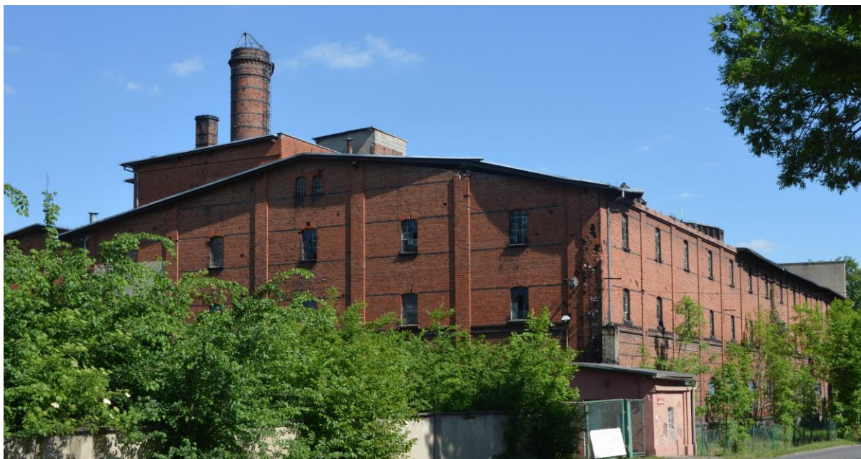
Abb. 12 Das Mälzereigebäude im Sommer 2018. Im Vergleich mit dem Bild aus dem Jahr 2015 fehlt im vorderen Teil an der Straße ein Teil der Bedachung und die eiserne Haube auf dem Darrfax
