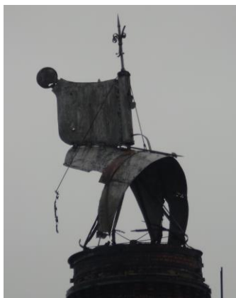
Abb. 13 Der eiserne Schutzschirm auf dem Darrfax im Jahr 2015
