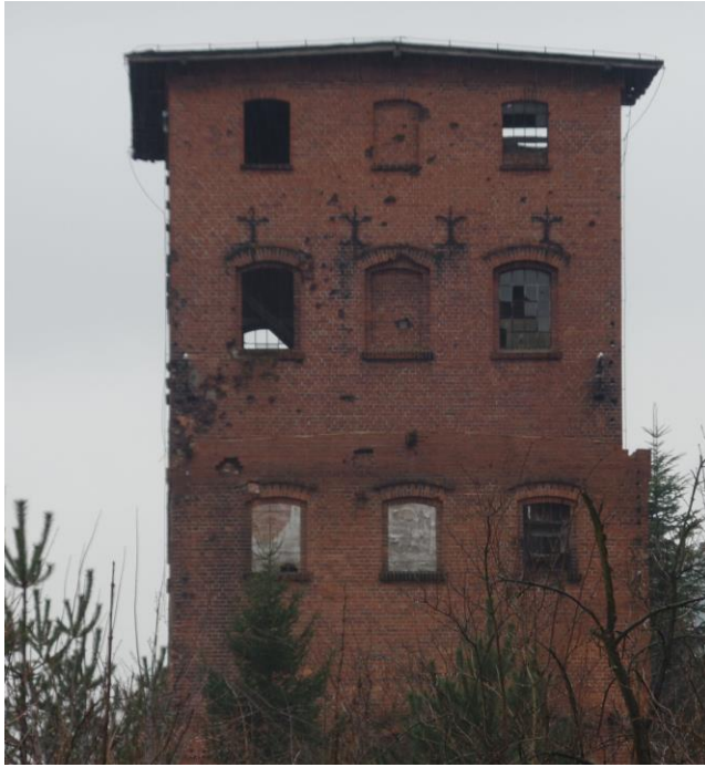
Abb. 14 Das ehemalige Sudhausgebäude im Jahr 2015
