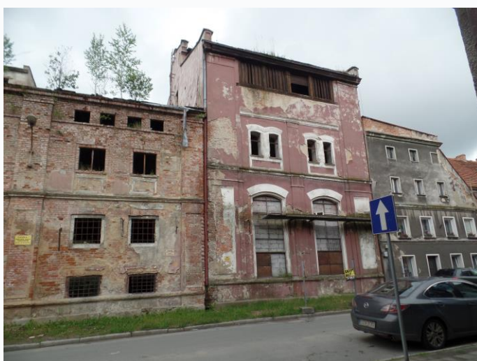
Zustand des 1888 errichteten Sudhausgebäudes im Jahre 2021
