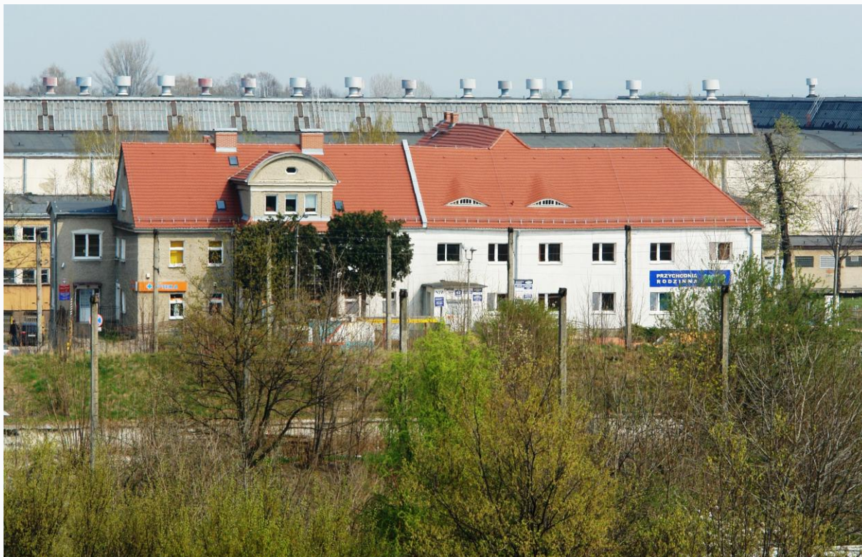
Heutige Ansicht der ehemaligen, baulich veränderten Gastwirtschaft, links das Wohnhaus, dahinter auf dem ehemaligen Gelände der Brauerei Kahl neue Gewerbebebauung (Sammlung Szyndler, Nysa, PL)
